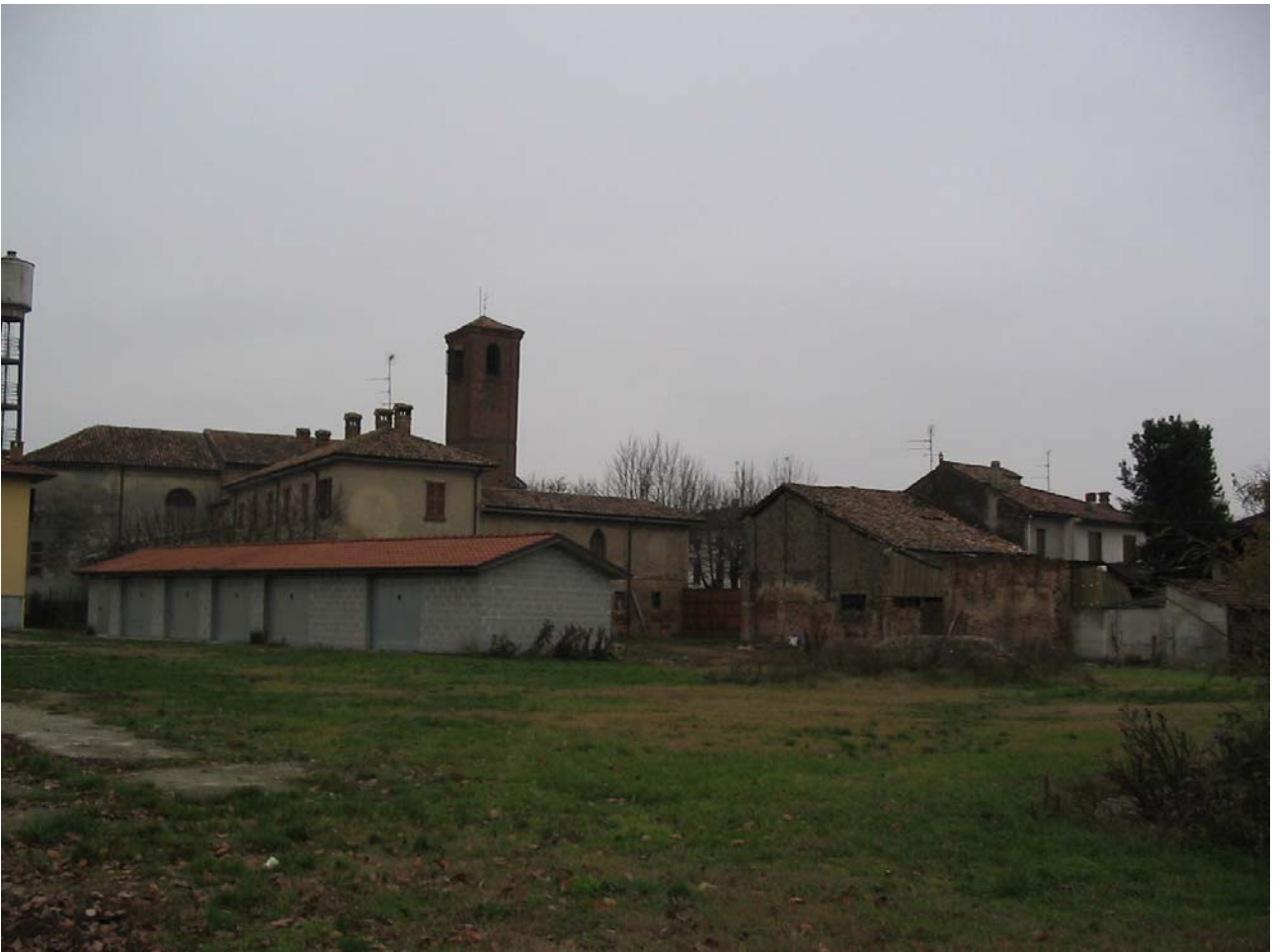
Figura 4 Finiture improprie in edifici recenti
