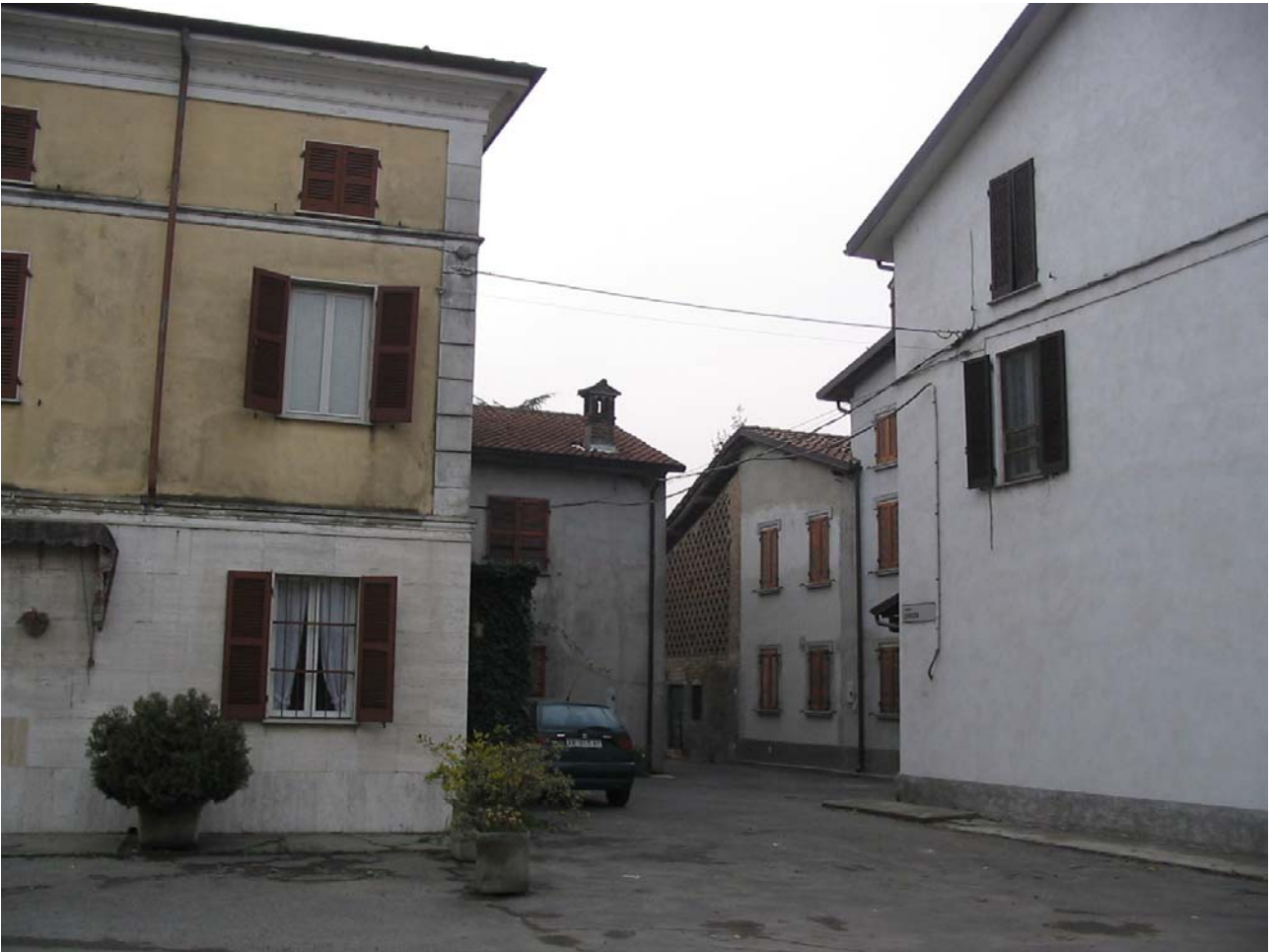
Figura 6 Edifici storici manomessi nelle finiture di facciata
