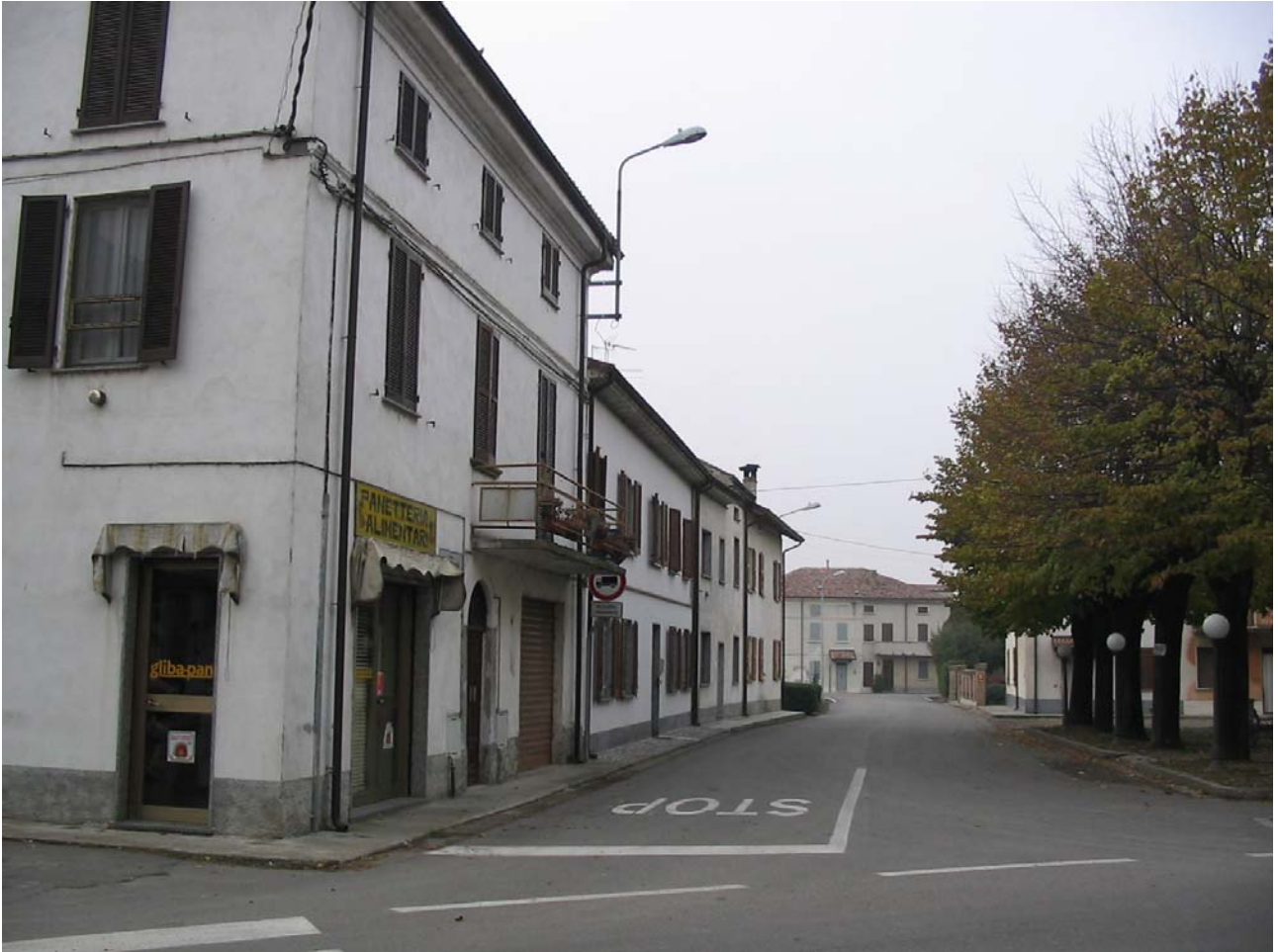
Figura 3 Edifici privi di tinteggiatura
