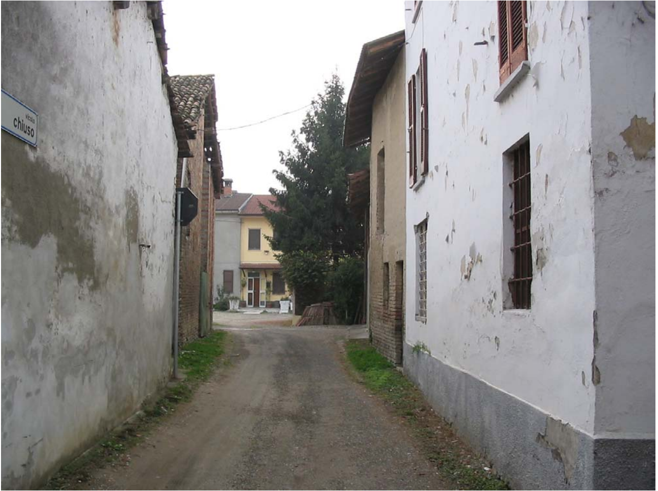
Figura 5 Elementi di degrado nel centro antico
